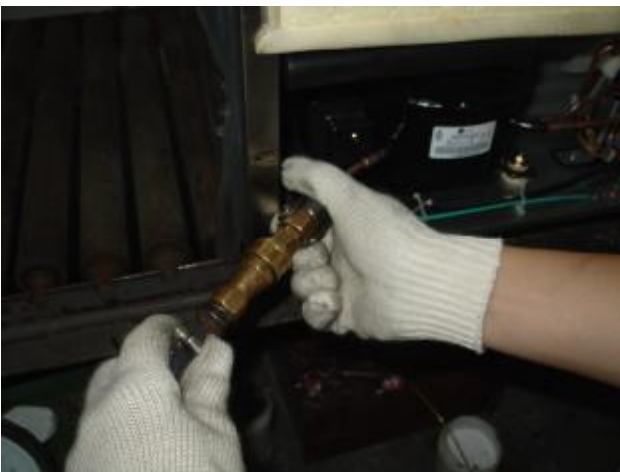
g. 检查各焊点，用带有肥皂水的毛巾轻轻掩住焊点，若有气泡，证明焊接有缝隙。
